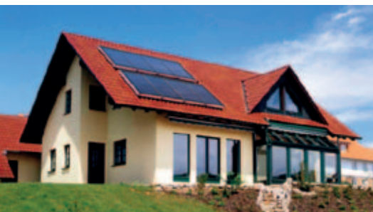
Montaža na streho
